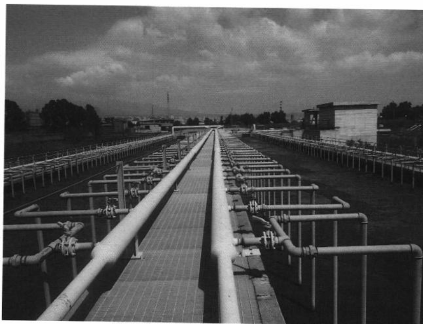
Impianto di Depurazione Pantano D'Arci CT Vasca di ossidazione - trattamento biologico acque reflue urbane
